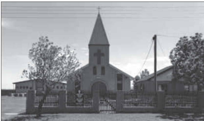
Slov. ev. a. v. kostol – Melbourne – Laverton, z pravej strany „stará“ fara, z ľavej práve dokončujeme spoločenskú halu
