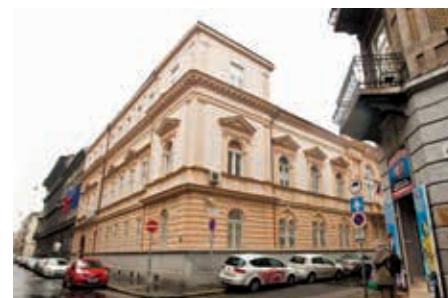
Budova ambasády ČSR v Budapešti Building of the Czechoslovak embassy in Budapest A Csehszlovák Köztársaság budapesti nagykövetségének épülete
